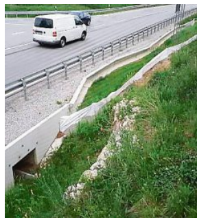
Einer der Durchlässe entlang der Weißlinger Umfahrung. FOTO: HVP
